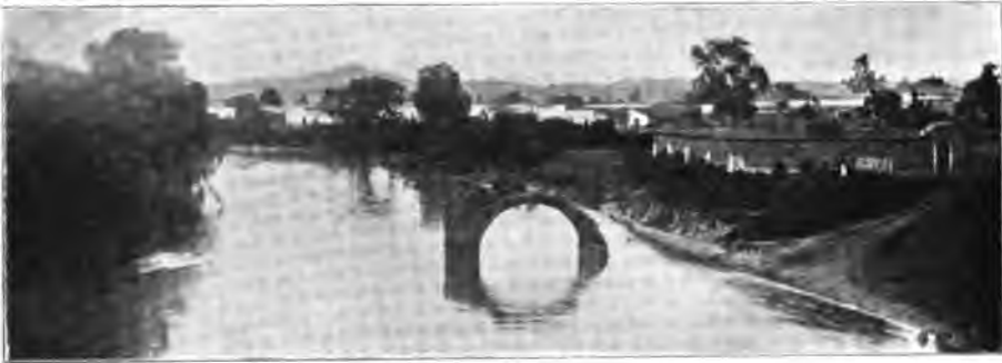
Alter Brückenbogen bei Acámbaro
